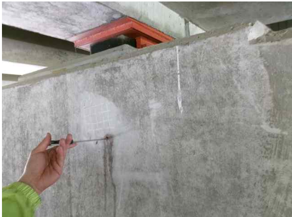
탄산화깊이 측정 현황
